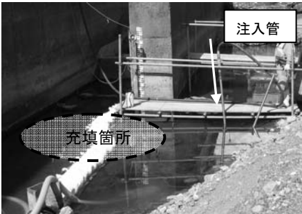
写真-7 充填状況
