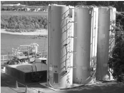
写真-5 プラント全景
