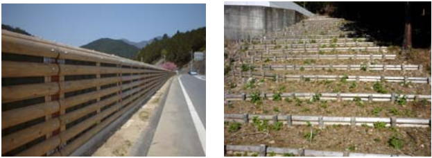
写真1 木製遮音壁（左）と丸太筋工（右）
