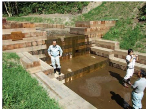
写真-1 オールウッド型木製治山ダム設置状況（左；11年経過，右；1年経過）
