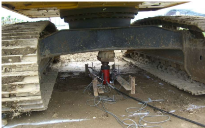
写真3 載荷試験の様子
