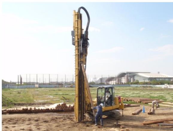
写真-1 実証実験に用いた丸太打設機
