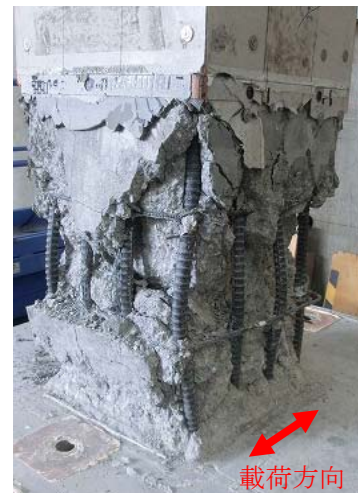
写真-2 柱基部の状況 (No.2, 実験終了後)
