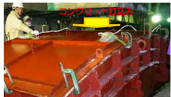
写真-1 セグメントの製作状況
