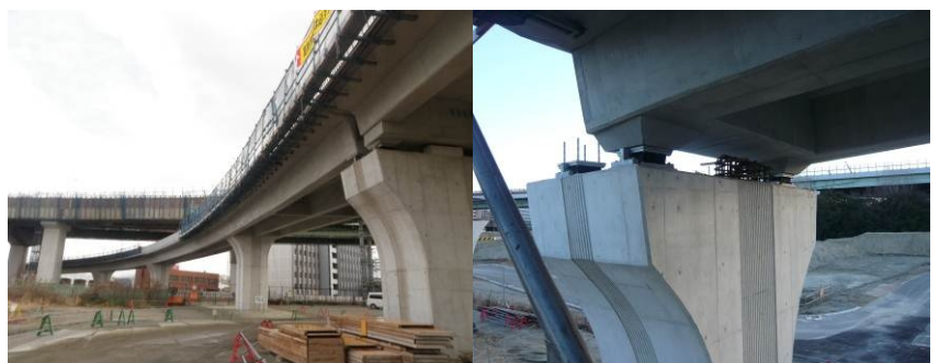
写真 1. 施工中の三宝 JCT.
