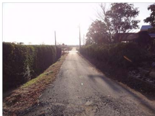
写真-1 上坂田地区横堤（堤内地側より撮影）
