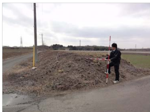
写真-2 田土部地区横堤（堤内地側より撮影）
