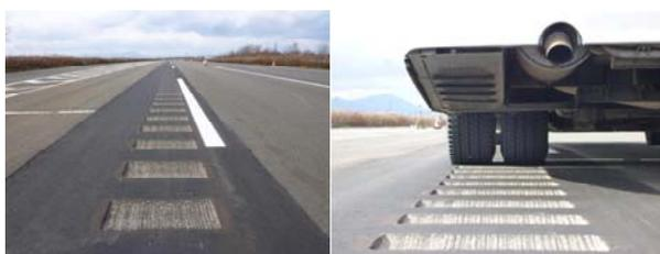
写真-1 大型車両対応規格のランブルストリップス
