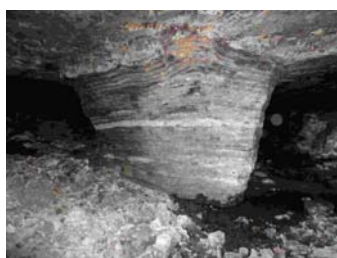
図-1 亜炭廃坑内の残柱（御嵩町）
