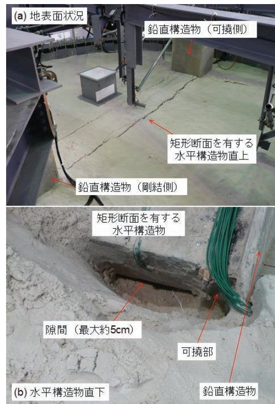
写真1：JR鷹取波50%入力後の試験体状況
