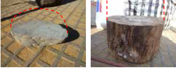
写真-1 切削状況(玉石及び旧木製電柱)
