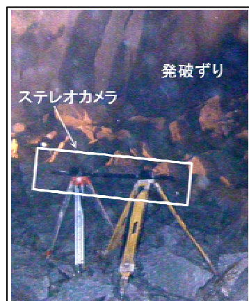
写真-4 現場でのステレオカメラ撮影状況
