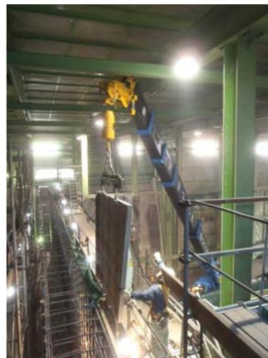
写真-4 埋設型枠設置状況
