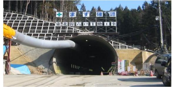
写真-1 不整形地盤中のトンネル坑口部
