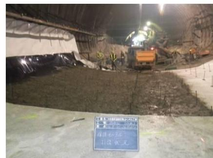
写真-1 保護モルタル打設状況
