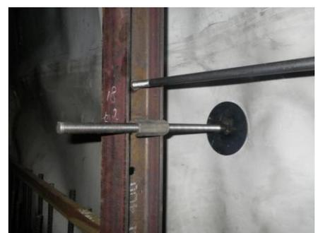
写真-3 円鉄板+段取り筋
