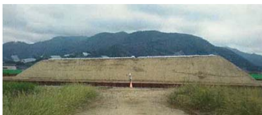
写真-1 試験盛土の施工状況 (エリア1)
