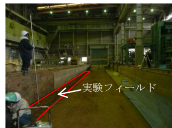
写真-2 沈下量測定状況
