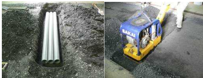
写真-2 塩ビ管の埋設及び埋設後の転圧状況
