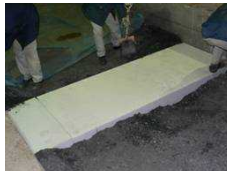
写真-1 EPS 埋設状況
