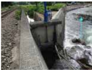
図-4 護岸壁下流端の取水設備
