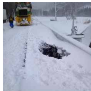
図-2 4月上旬に発生した陥没
