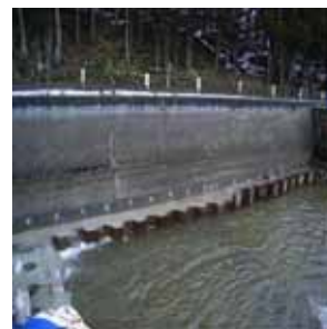
図-9 矢板工打設
