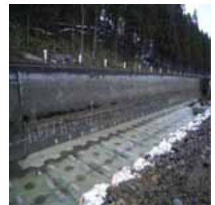
図-10 護床工構築
