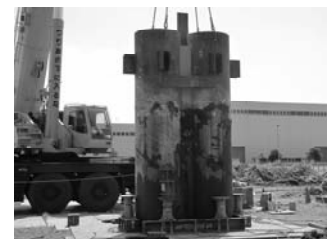
写真-4 引き抜き状況
