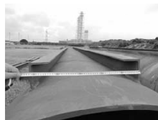
写真-1 試験杭（高耐力）
