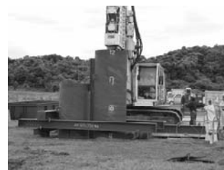
写真-3 打設状況
