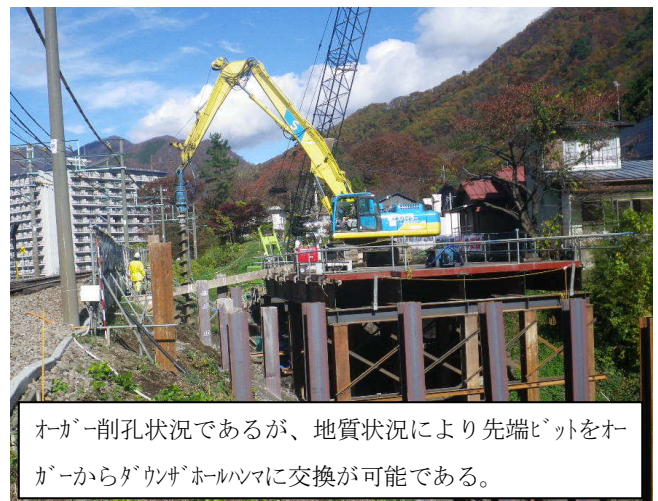
写真-3 セーフティーオーガー施工状況
