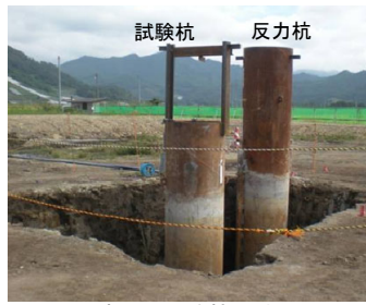
写真-1 試験杭の状況
