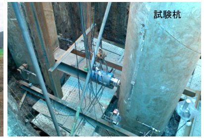
写真-2 水平載荷試験の状況
