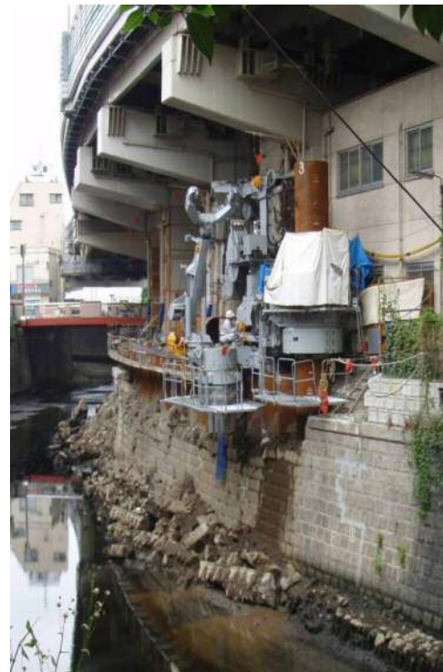
図1 回転圧入の施工の様子
