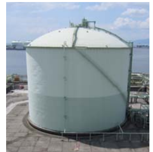
写真 1 LNG タンク全景
