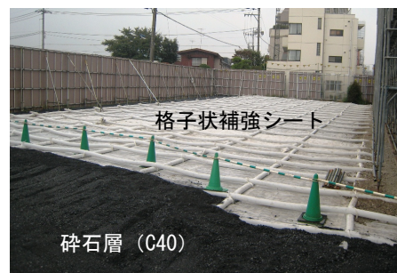
写真1 格子状補強シート設置状況
