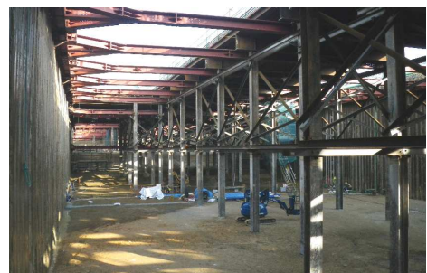
図-6 床付け完了時の状況
