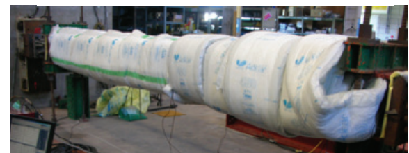
写真-2 保温材巻き付け状況
