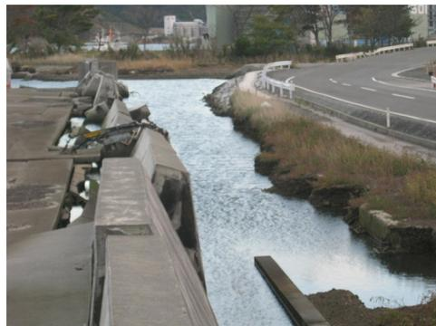
写真-1 胸壁背後の洗掘による被災例 (大船渡港茶屋前地区)
