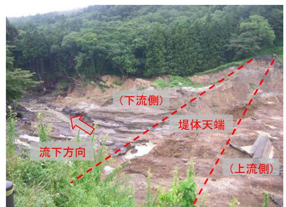
写真 1 地震により破堤したため池
