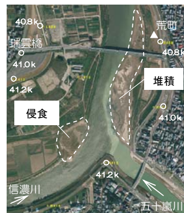
写真-1 H23年7月洪水後の状況
