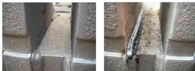
図6 狭隘部の溶接復旧状況（復旧前・後）
