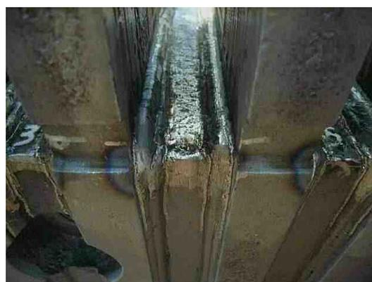
図8 溶接止端部の処理状況
