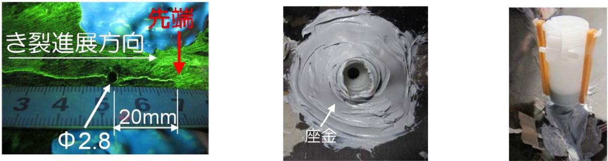
(a)先端近傍のき裂上から非貫通孔φ2.8を導入 (b)ドリル孔にシーリング材で座金を接着 (c)座金に低圧注入器具を取付
