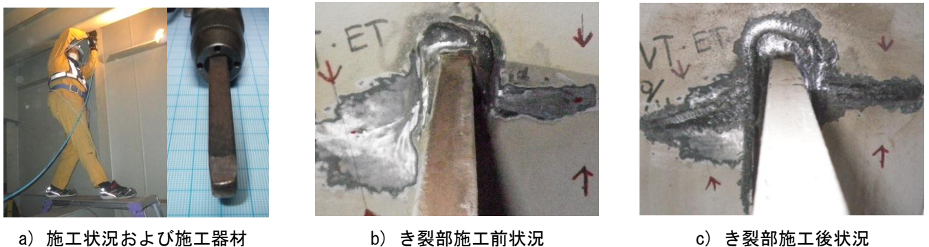
写真-1 ICR 処理の施工状況およびき裂部の施工前後状況
