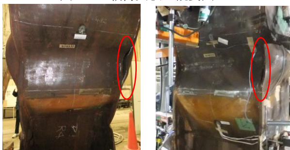
図 2.2 局部座屈が生じた斜材位置
