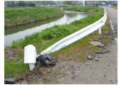
写真2 飛散物による破損
