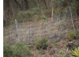
図-1 ワイヤリング落石防護柵
