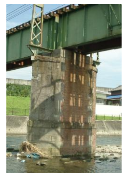
図2 実橋脚の外観
