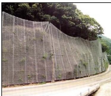
写真-1 落石防護網
