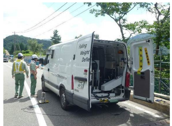
写真-1 FWD を用いた載荷試験
