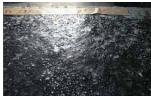
写真-3 TCM 人力施工 数均し温度 110℃
