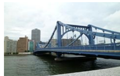
写真-1 清洲橋全景
