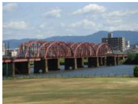
写真-1 紀ノ川橋梁
