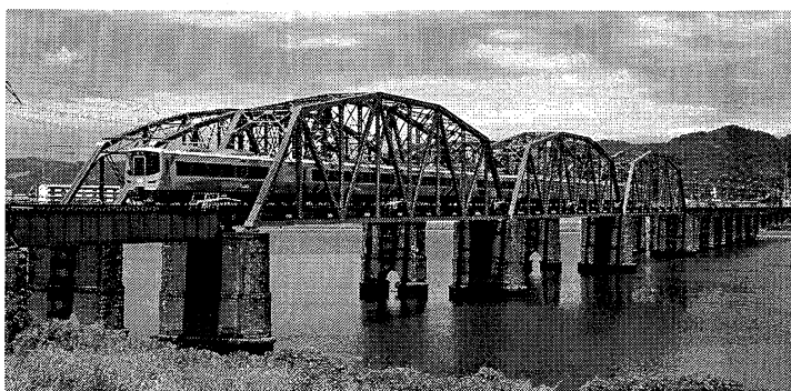
図-1 南海線紀ノ川橋梁全景 (写真手前が上流側である下り線)
