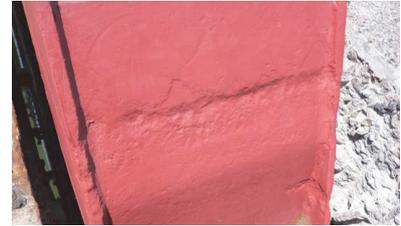
図-1 トラス斜材の腐食状態の一例
