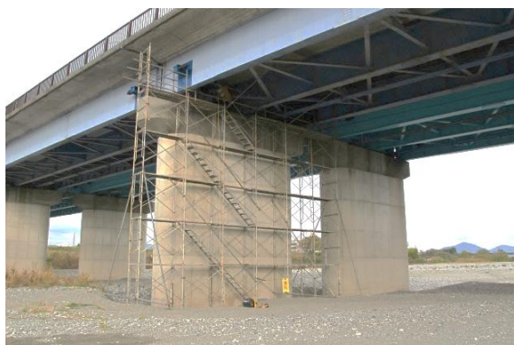
図-1 調査対象橋梁状況
