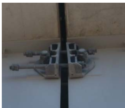
写真-2 鋼材設置前
