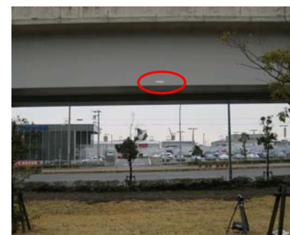
写真-4 HDVC による橋桁の計測状況
