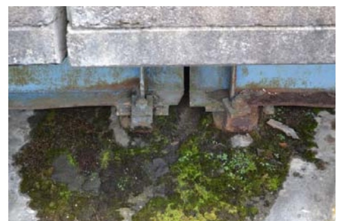
写真-3 支点部の状況
