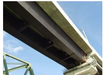
写真-1 対象橋梁
